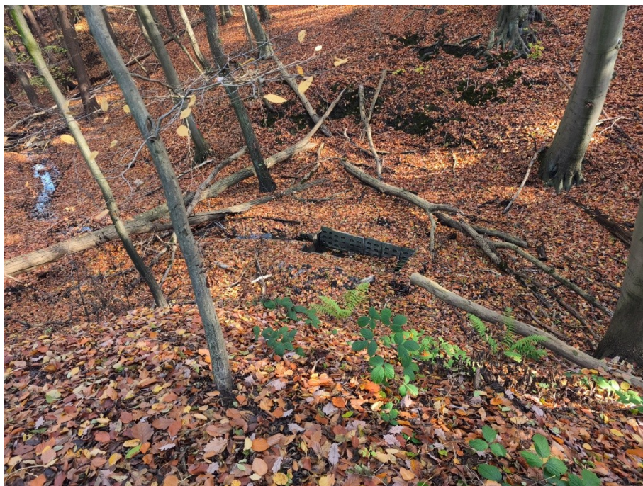
Fot. 6. Oczyszczony przepust u podstawy osuwiska.
